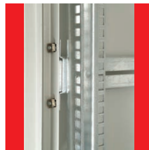
Detail spojení skeletu
