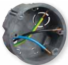
Montáž přijímače do instalační krabice
