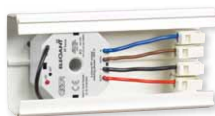
Montáž přijímače do kabelových žlabů a kanálů
