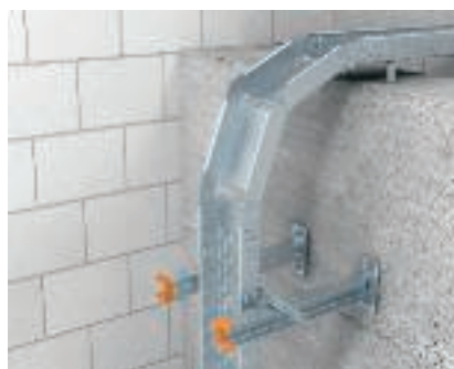
Montáž kloubového oblouku svislého, klesajícího
