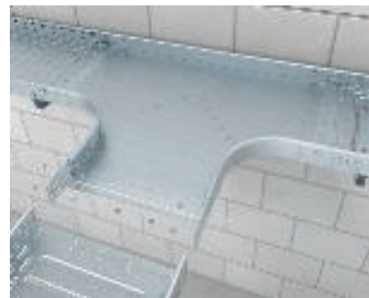
Montáž odbočného dílu T (šířka 400 - 600 mm)
